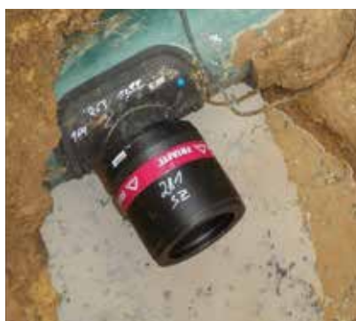
Siodło kanalizacyjne ASA VL z mufą przejściową AMKG d225/DN200
