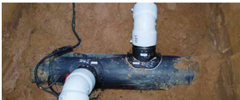
Kolana kanalizacyjne FRIAFIT ABM w zastosowaniu.
