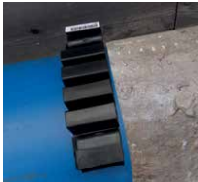
Zastosowanie jako zabezpieczenie przed wciągnięciem przy renowacji rury
