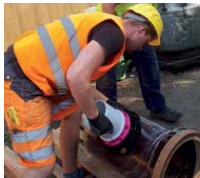
Prezentacja bezpośrednio na budowie.
