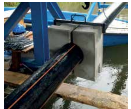
Zastosowanie jako zamocowanie do ciężarów zatapialnych przy rurociągach
